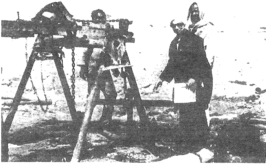
٩- حفرة بئر مياه جوفية لاستصلاح الأرض
