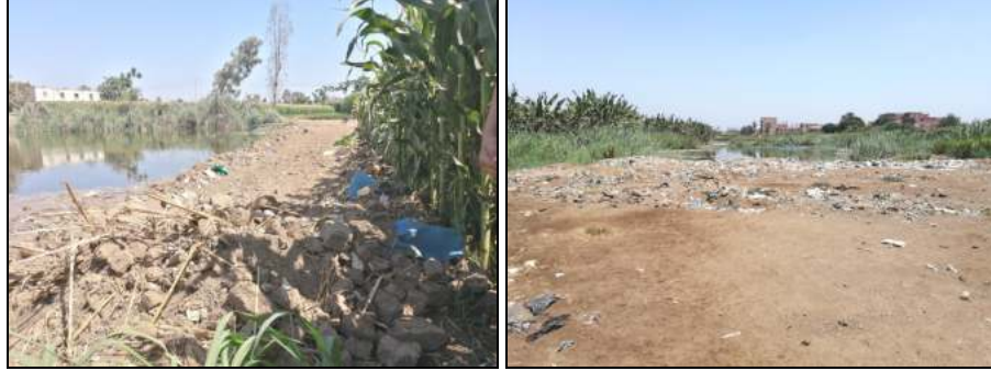
صورة (١) تعديات الردم بقطاع الخزانيين (الأوسط- الجنوبي)
