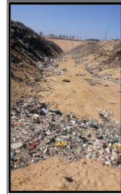
صورة (٦-٧) الفاصل بين الخليتين والذي تشغله غرف تصريف العصارة تتصل في نهايتها ببئر تجميع ومرشح بيولوجي تستخدم مياهه في أعمال الإطفاء
