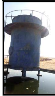
صورة (٦-٧) الفاصل بين الخليتين والذي تشغله غرف تصريف العصارة تتصل في نهايتها ببئر تجميع ومرشح بيولوجي تستخدم مياهه في أعمال الإطفاء
